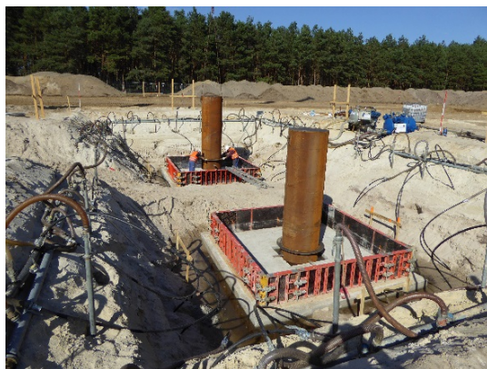
Abb.: links: Bau des Bohrkellers mit Bohransatzpunkten; rechts: innerer und äußerer Bereich des Bohrplatzes
